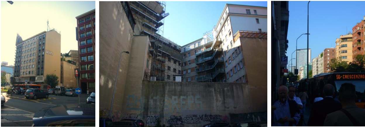
Foto dello stato di fatto, un vuoto urbano adibito a parcheggio occasionale all'interno di un isolato molto compatto
